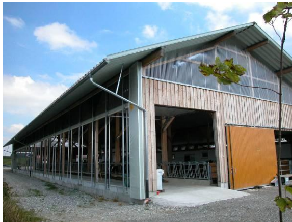
Hell und luftig präsentiert sich der Stall. Die Westseite lässt sich mit aufrollbaren Curtains öffnen. Hier könnte ein ebenso großer Stall angebaut werden.
