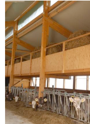
Jungviehstall mit Shed- dach und Strohbühne
