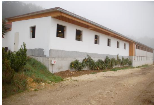
Dieser Anbau beherbergt den Melkstand
