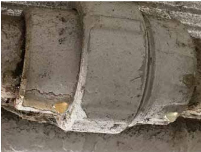
Abbildung 6: Undichte Verschraubung einer Milchleitung.
