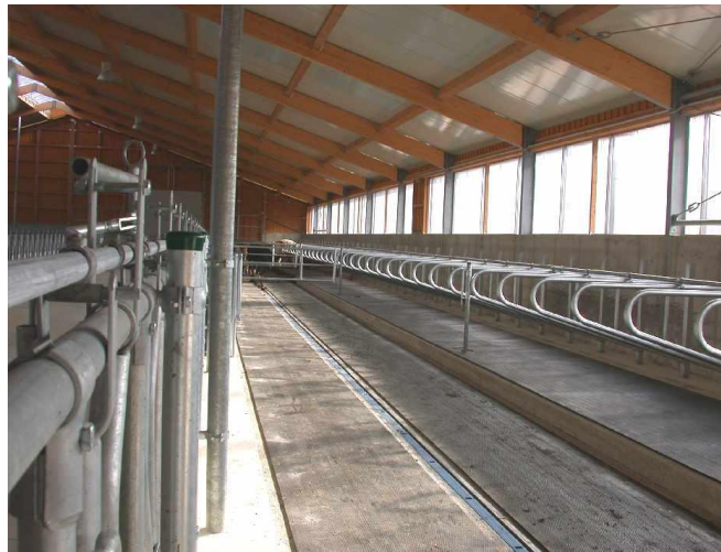
Die Jungviehseite wurde mit Hochboxen ausgestattet.
