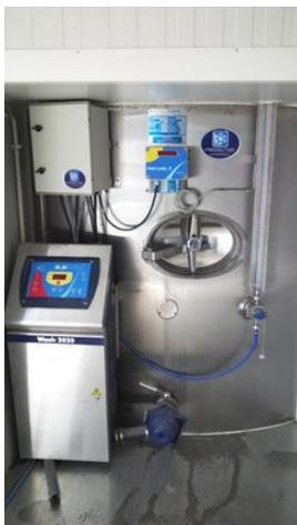
Schleuse: Die neue System-Happel Schleuse (aus 50 mm dicken Sandwich-Elementen) verbindet den außen am Gebäude installierten Silo-Milchtank mit der Milchkammer und bürgt so für eine sichere Milchkonservierung, da die Bedienung und Steuerung aller Abläufe (Befüllung, Milchabholung, Reinigung) in der Milchkammer erfolgt. Zudem werden so die Reinigungssysteme effizient vor Frost geschützt.
