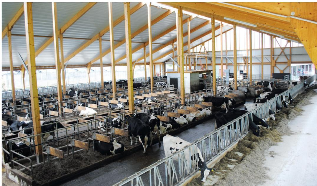
Durch das helle Dach, große Giebeldreiecke und zwei offene Seiten ist der Stall der Familie Eitenmüller sehr hell und luftig. Foto: Eitenmüller
